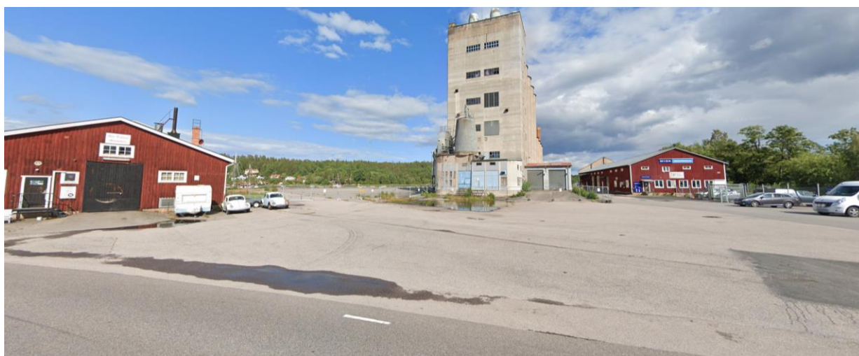
Figur 5-3 – Översikt över silon och industribyggnader med hamnområdet i bakgrunden. Bild tagen från Varvsgatan i riktning öst (Google, 2023).
